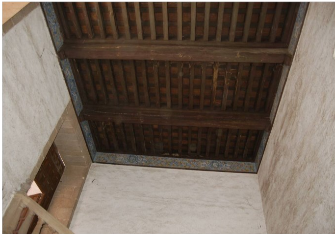
Figura 4: Estado inicial de la escalera principal del edificio histórico Palacio Carvajal/Girón.
